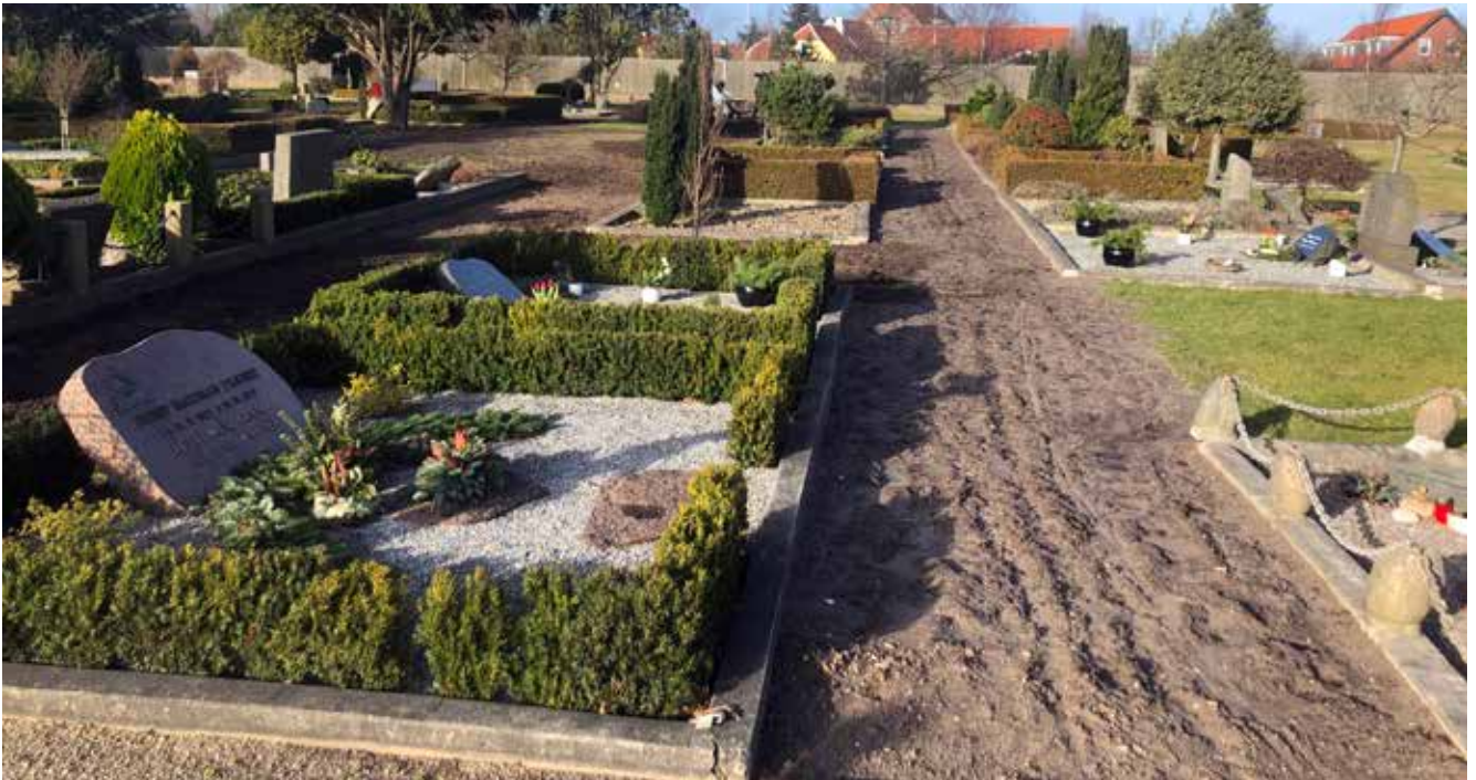
Grus gange er i etaper ved at blive omlagt til græs.
